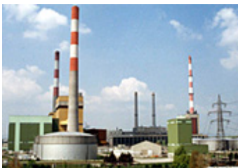
Autriche, Simmering, 65 MW
